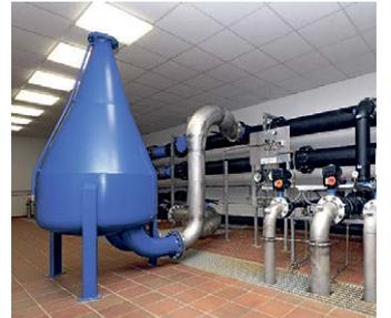
Damit es nicht tröpfelt, sondern ordentlich aus allen Hähnen sprudelt, drücken 15 Pumpen und sieben Druckerhöhungsstationen das Trinkwasser ins Netz und sorgen für einen stabilen Druck.
