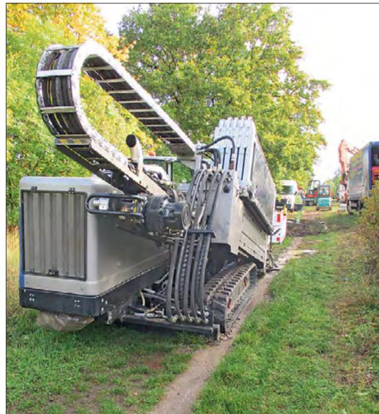
Die Abwasserdruckleitung wurde überwiegend im Horizontalbohrverfahren verlegt. Foto: WAZ Seelow
